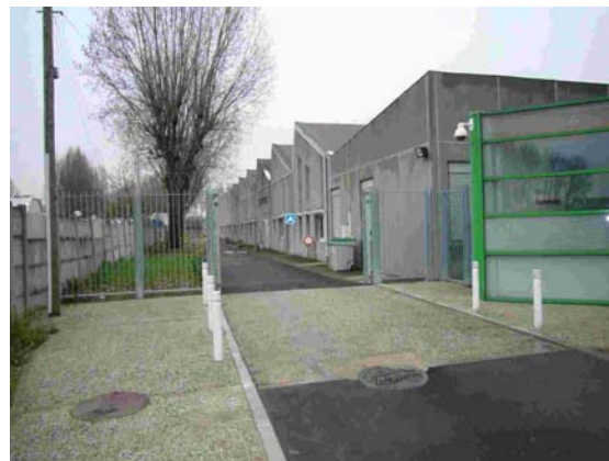
Photo 4 : une caméra sur une entrée livraison
